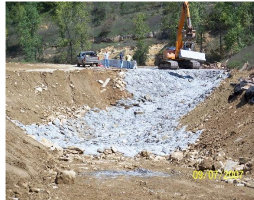
Bad Axe 12 Aux. Spwy Repair – Sept. 2007
